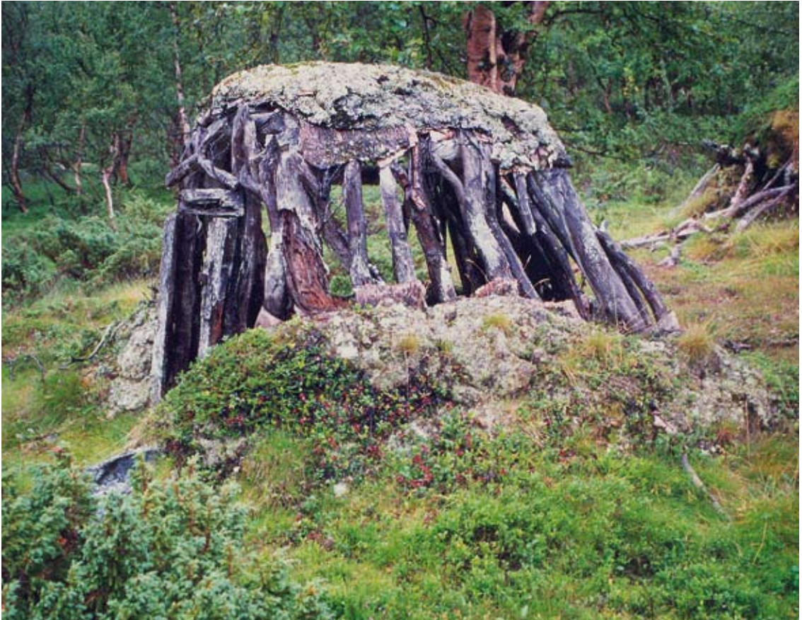
Torv och näver har rasat ned från kåtans väggar och träkonstruktionen syns som ett skelett.
